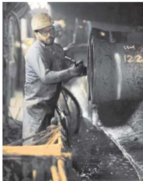
Рис. 11. Участок антикоррозийной обработки труб
